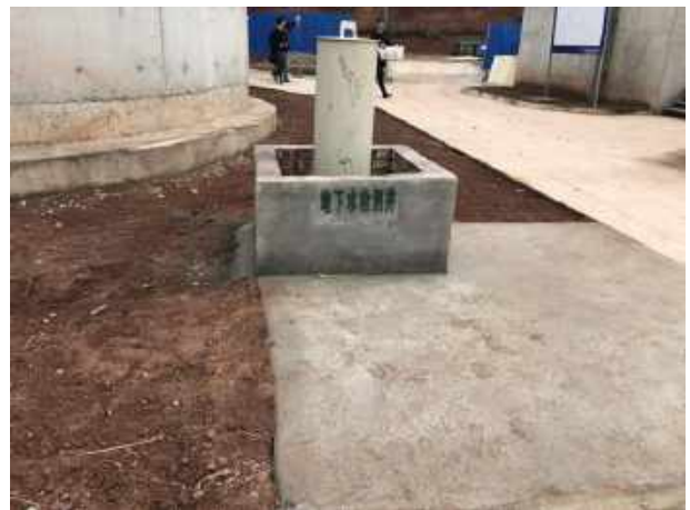
地下水现场监测
